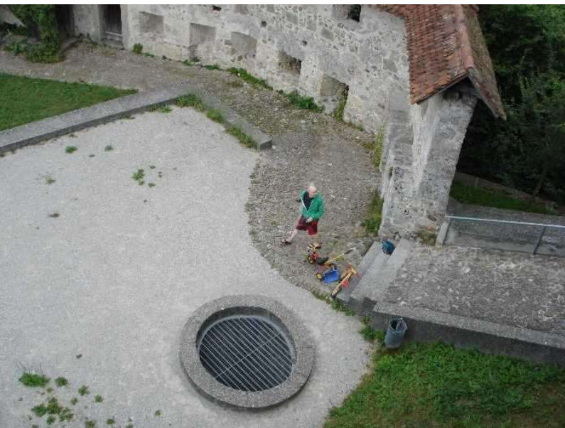
Sodbrunnen Mit ursprünglicher Tiefe von 30m
