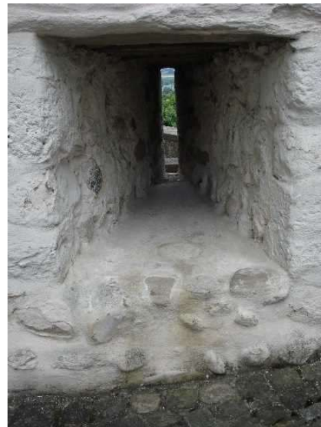
links, bodennahe Belüftung des Schlosshofes
