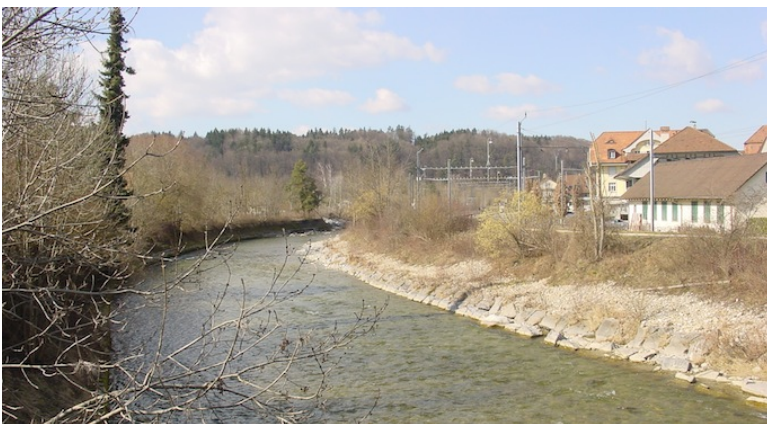
Dieue Sense im Siedlungsgebiet von Laupen. (Foto: Flussbau AG SAH)
