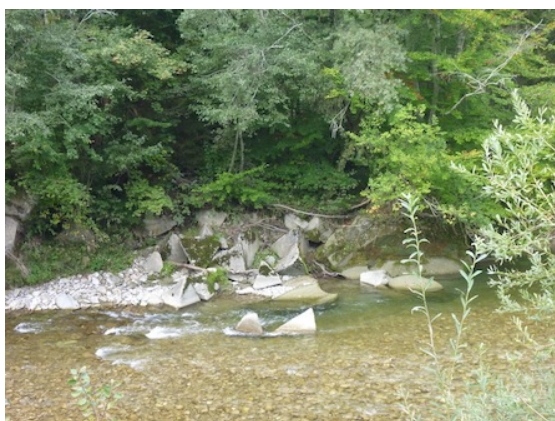
Beschädigter Uferschutz im Bereich Gäu / Büffel. (Foto Flussbau AG SAH)
