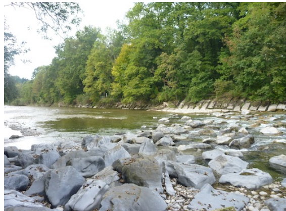
Betonquader im Bereich Neuenegg, Blick flussabwärts von Blockrampe bei km 5.6. (Foto Flussbau AG SAH)
